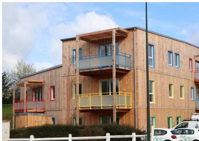
Figure 15 : Résidence rue Criquetière |Bretteville sur Laize (14) | Bepos Effinergie 2017 |MO : Inolya |Architectes : Knapp et François Versavel Architectes
