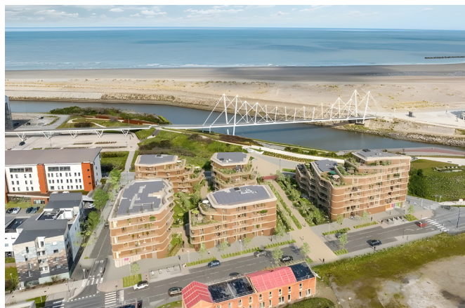
Figure 13 : Résidence Héliante | Effinergie RE2020 | Architecte : Coldefy | Dunkerque (59)
