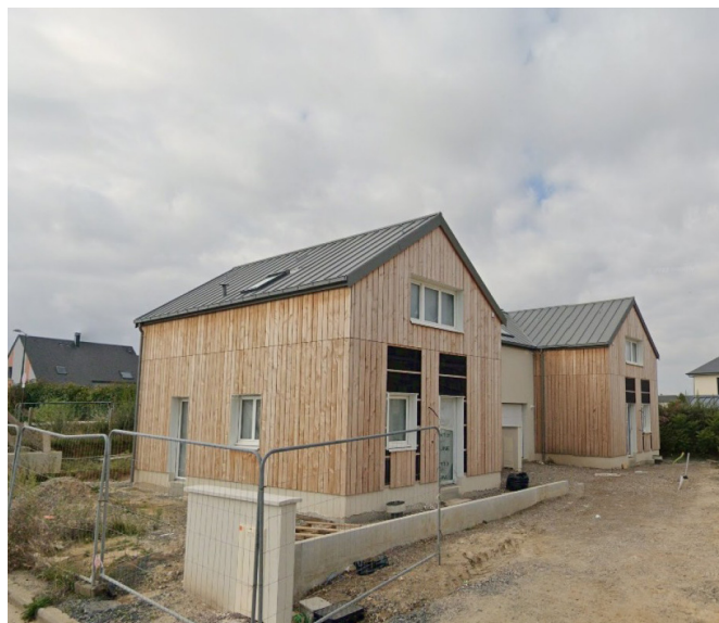
Figure 16 : Rue Lemarchand|Bepos Effinergie 2017| Architecte : JV Archi & associés | MO : Inolya
